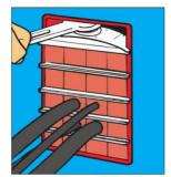
Die Telekopschraube der Pressplatte anziehen bis der Abstand zwischen Oberseite Pressplatte und Innenseite Rahmen 32mm beträgt.
