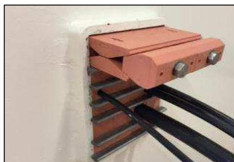
Die Pressdichtung zwischen Ankerscheibe und Rahmen einsetzen.
