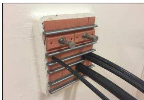
Die Pressdichtung kann überall im Rahmen positioniert werden.
