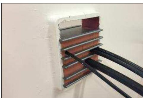
Den Rahmen wie in der Montageanleitung beschrieben füllen. Abschliessend eine Ankerscheibe einlegen.
