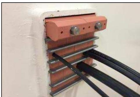
Die Pressdichtung soweit einschieben bis diese in der Ankerscheibe einrastet.
